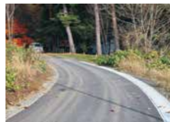
農道戸田五郎沢線工事箇所
