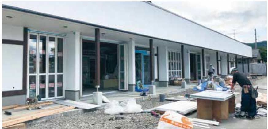
増改修工事が進むオドデ館
