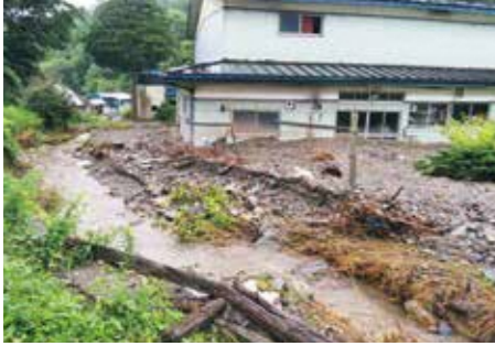
洪水により住宅浸水した現場(黒沢地区)
