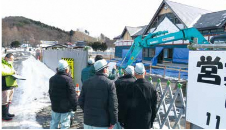
オドデ館の工事現場を視察する議員
