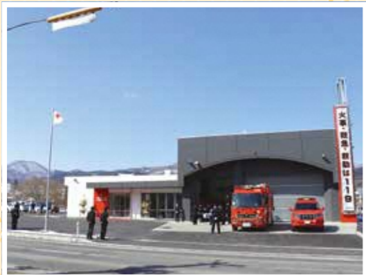
懸案であった九戸分署庁舎が落成
