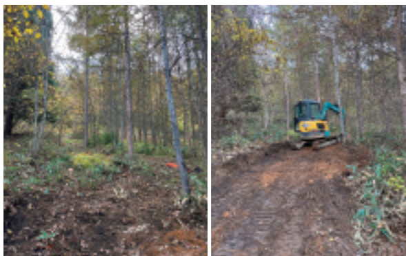
作成途中の作業道。 周辺の木々を間伐しながら道を作っています。
