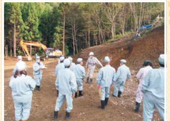
10月7日に行われた風力発電の盛土崩落現場視察
