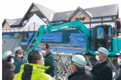
増改修工事が行われているオドデ館
