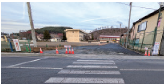
国道からの進入口（工事中）
